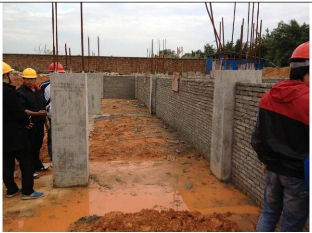
认识基础承台、基础梁、柱及其节点
