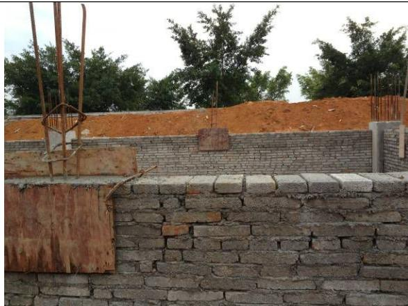
认识墙体中的构造柱、指出构造柱设置的不合理之处
