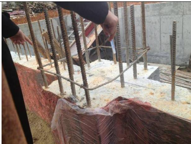
认识柱钢筋（纵向受力钢筋、箍筋）
